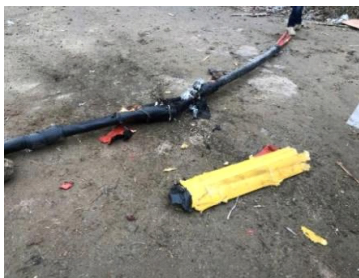
图1 爆炸现场实物
